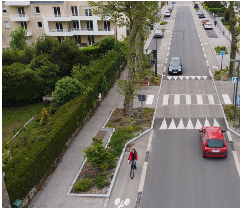
La Route de Vannes : l'aménagement redistribue l'espace public où piétons, vélos et voitures disposent d'une voie dédiée pour circuler en toute sécurité.
